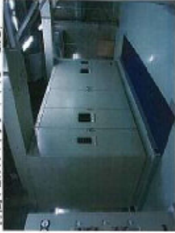
特高72kVスイッチギヤ(C-GIS)
