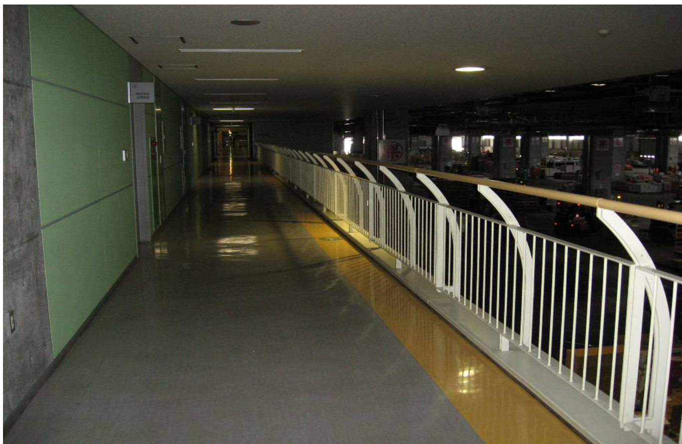
青果棟 2階見学者通路手すり及び壁
