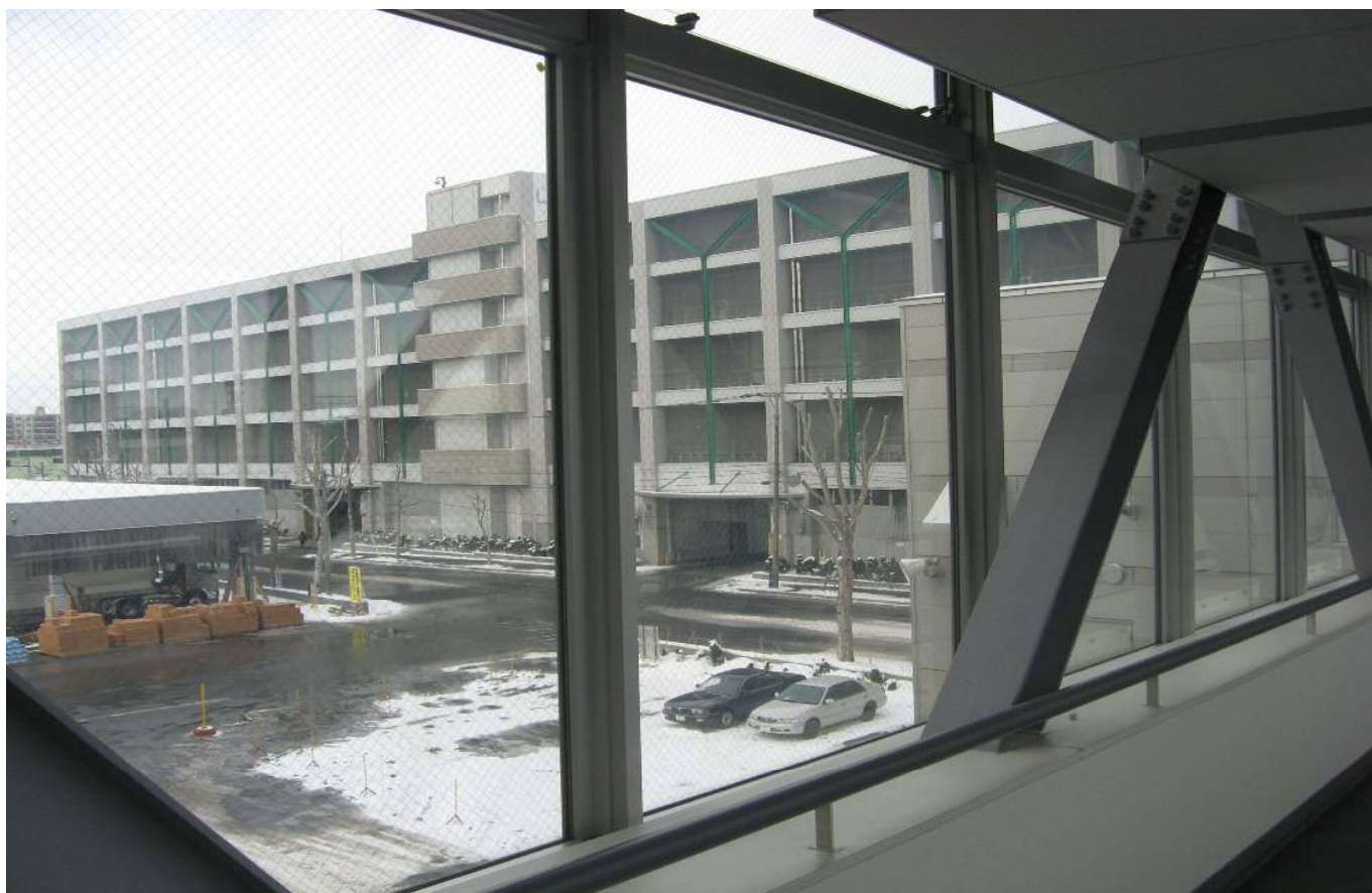
渡り廊下窓ガラス（内側）
