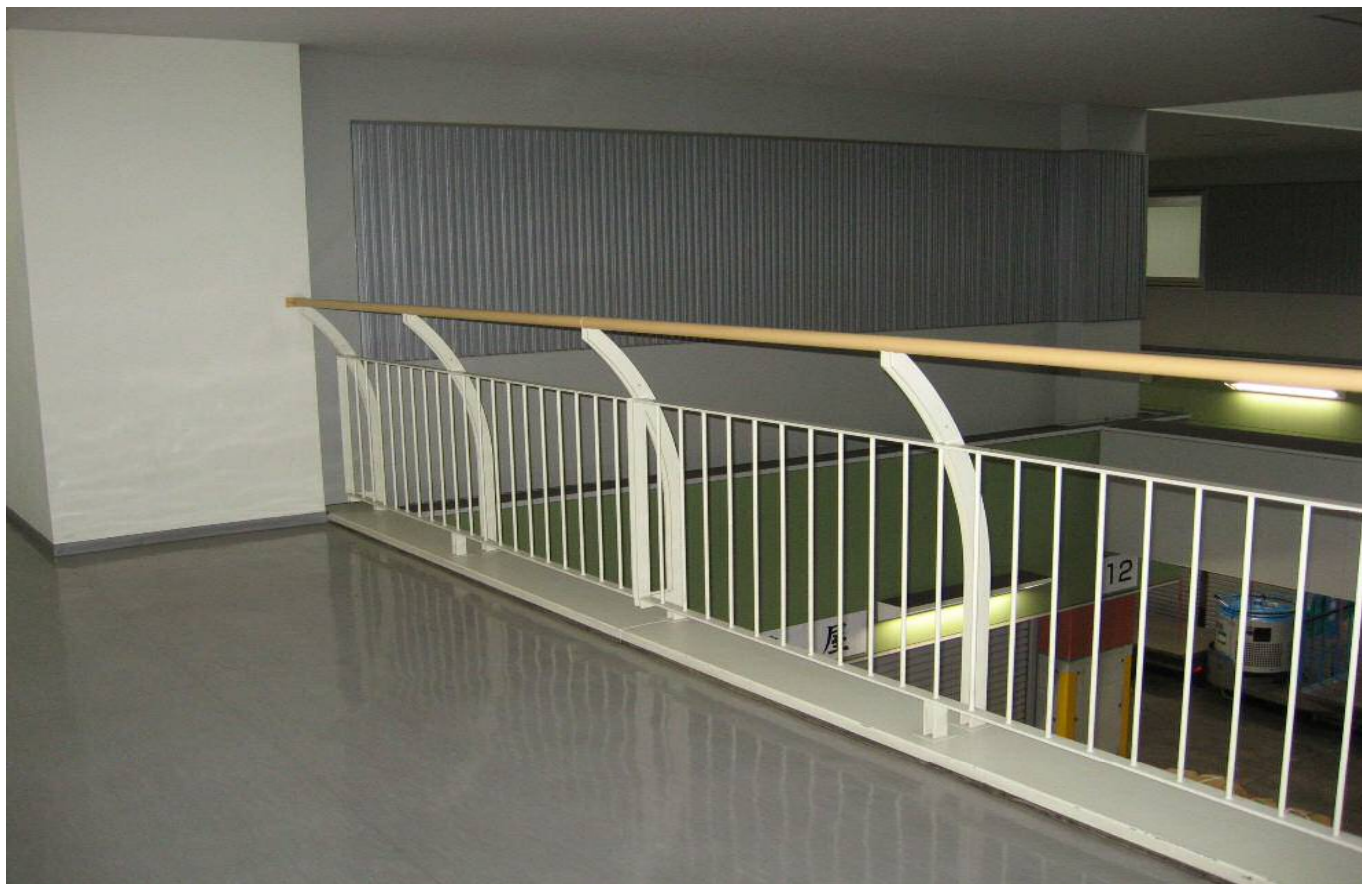
青果棟 2 階仲卸事務所通路側手すり
