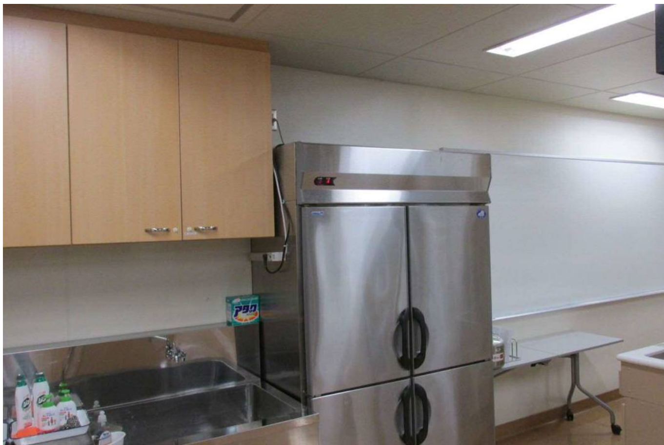
調理実習室内冷蔵庫の上部
