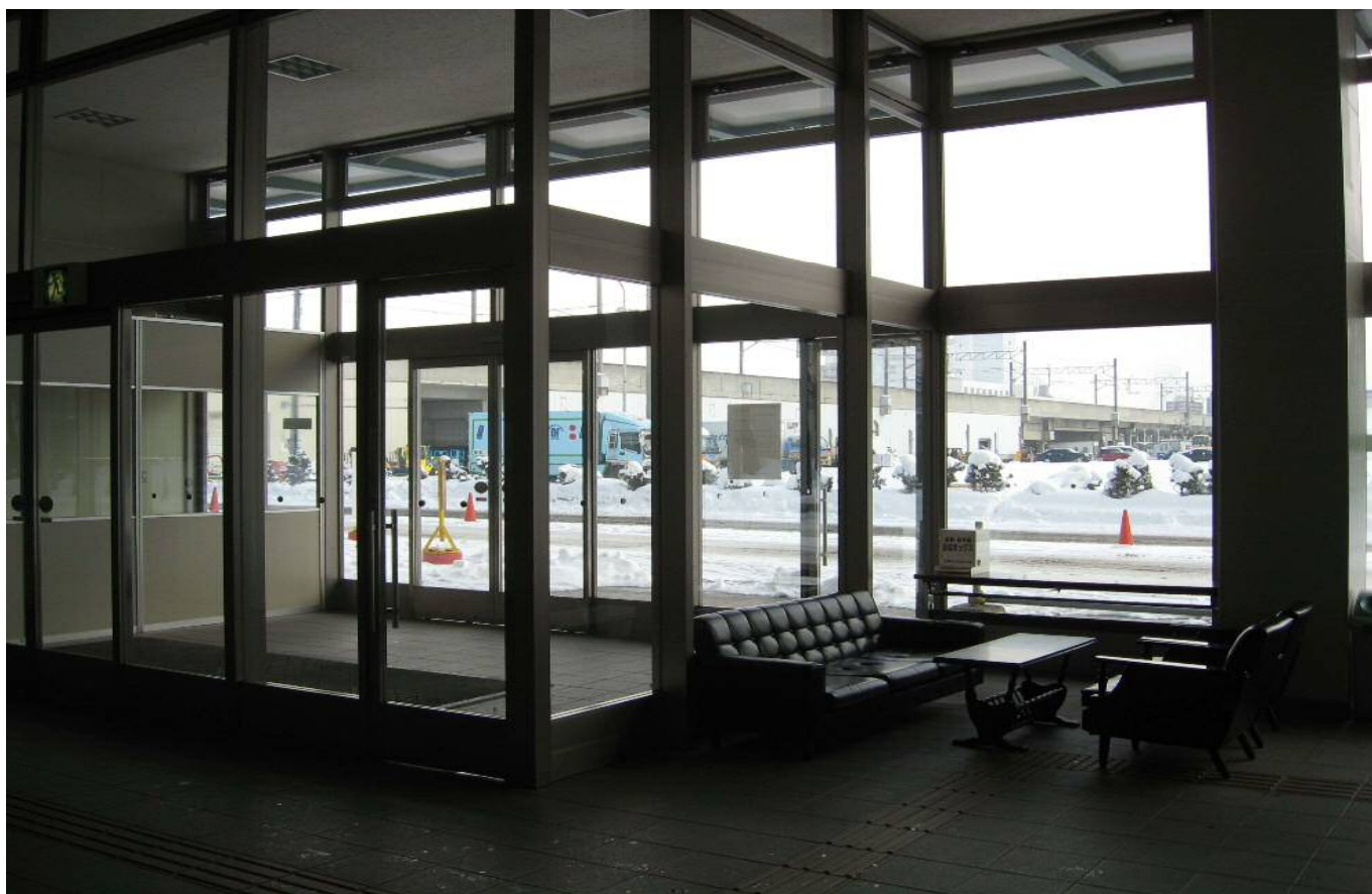
立体駐車場 1 階窓ガラス
