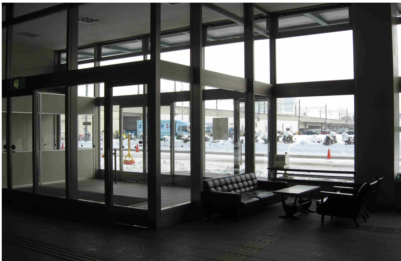
立体駐車場 1 階窓ガラス
