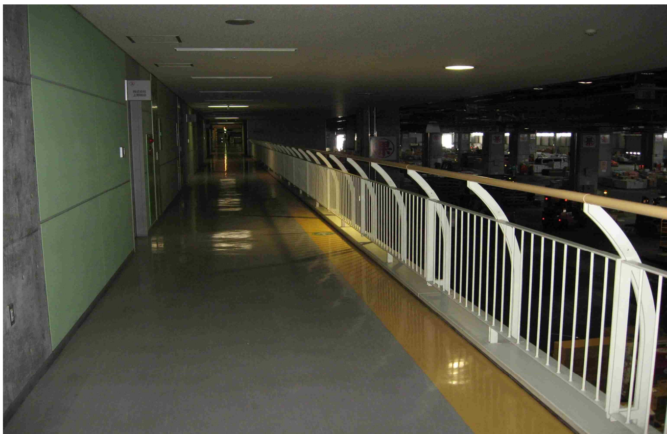
青果棟 2階見学者通路手すり及び壁
