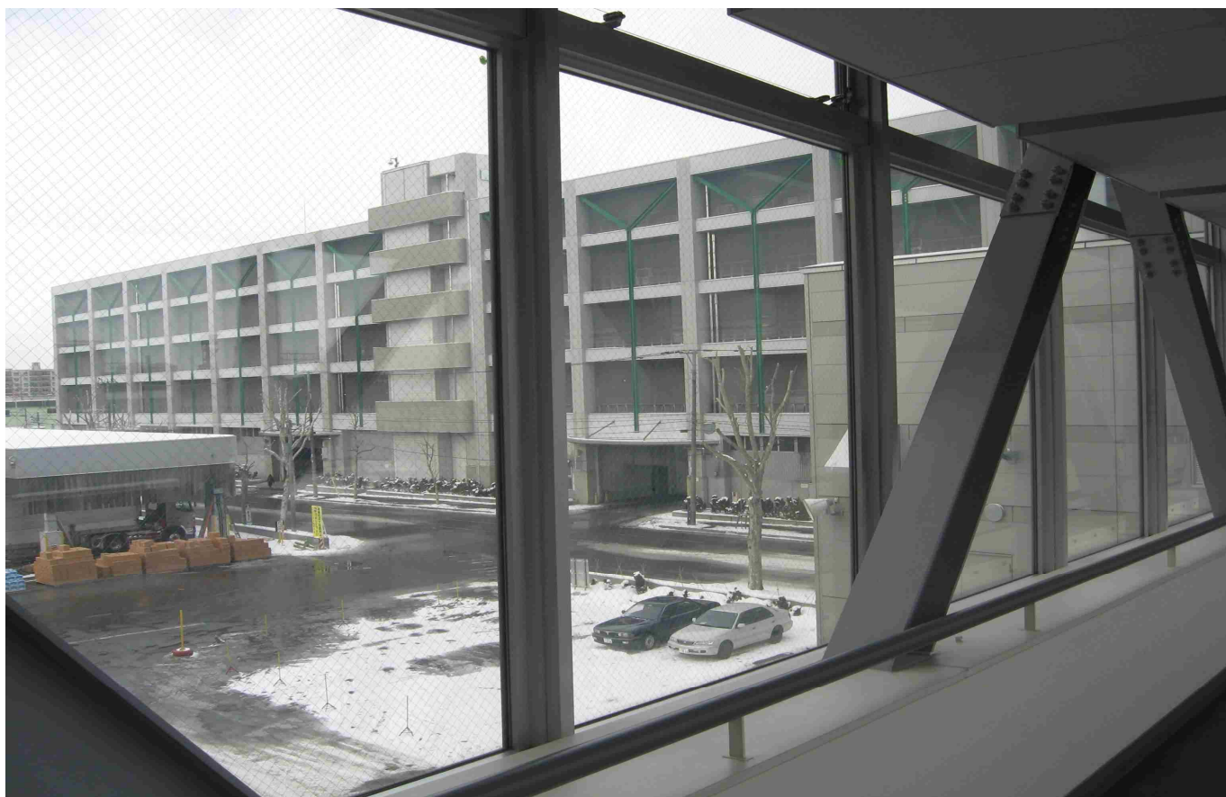
渡り廊下窓ガラス（内側）
