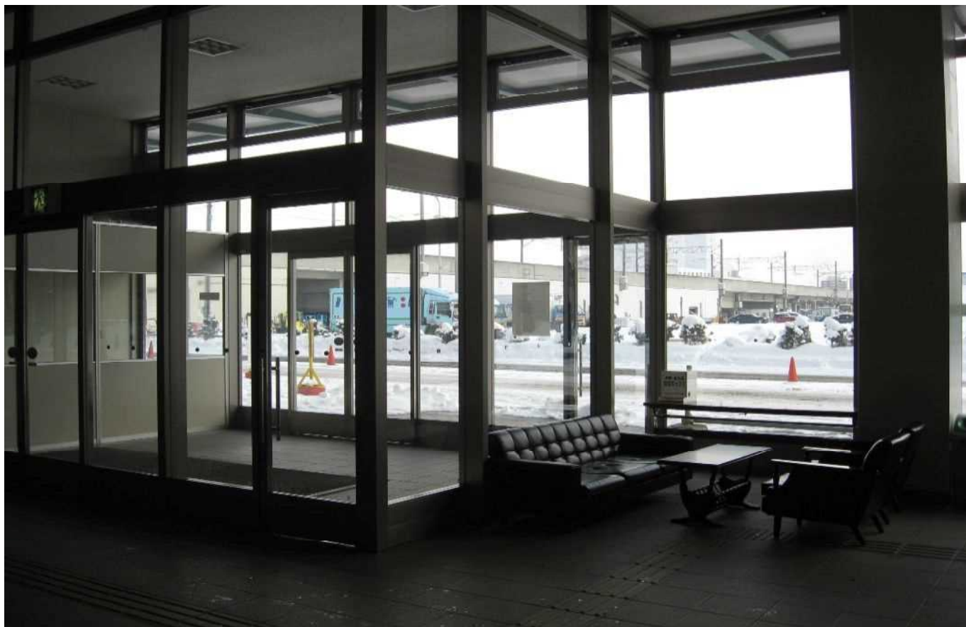
立体駐車場 1 階窓ガラス
