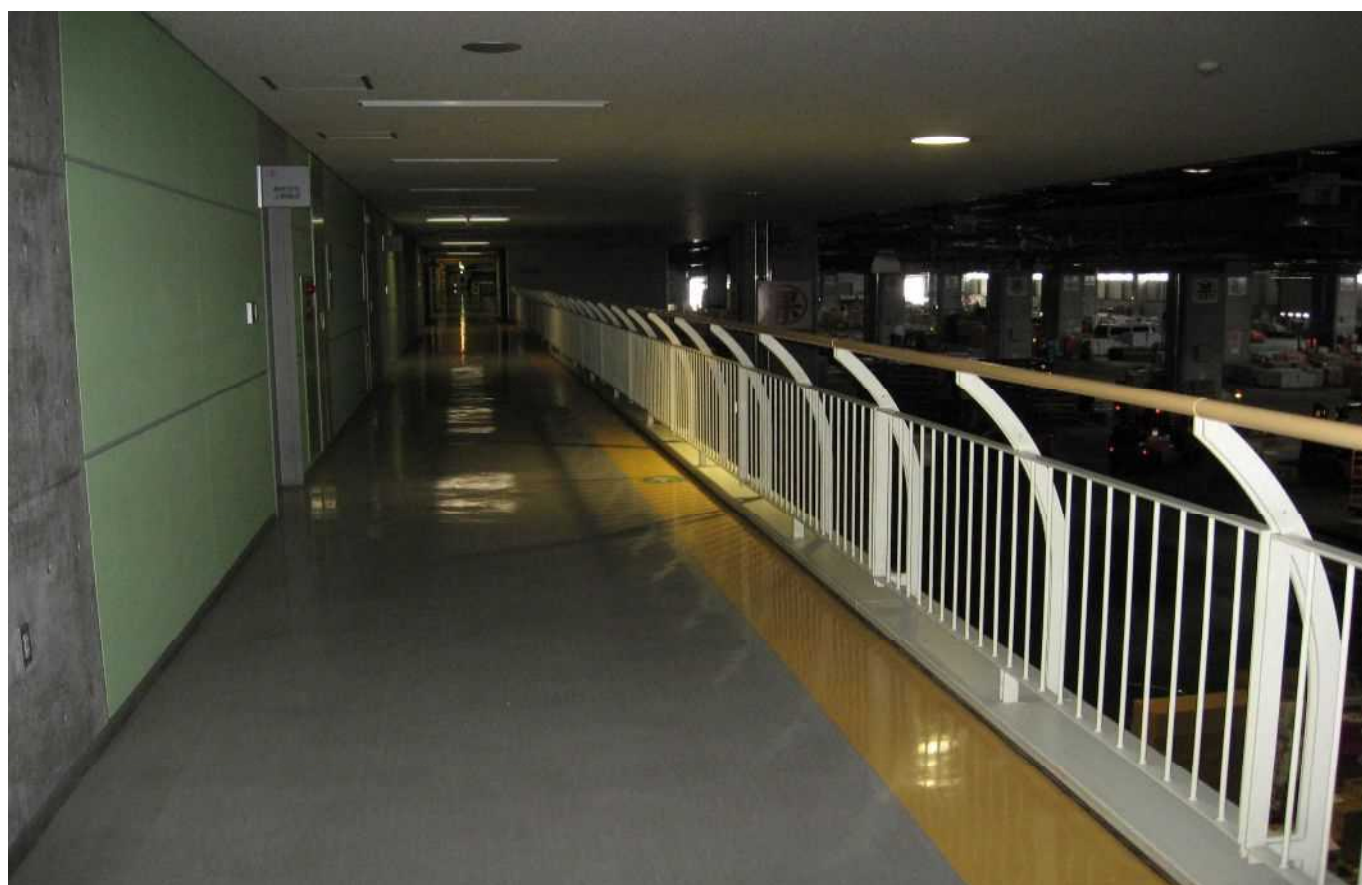
青果棟 2階見学者通路手すり及び壁
