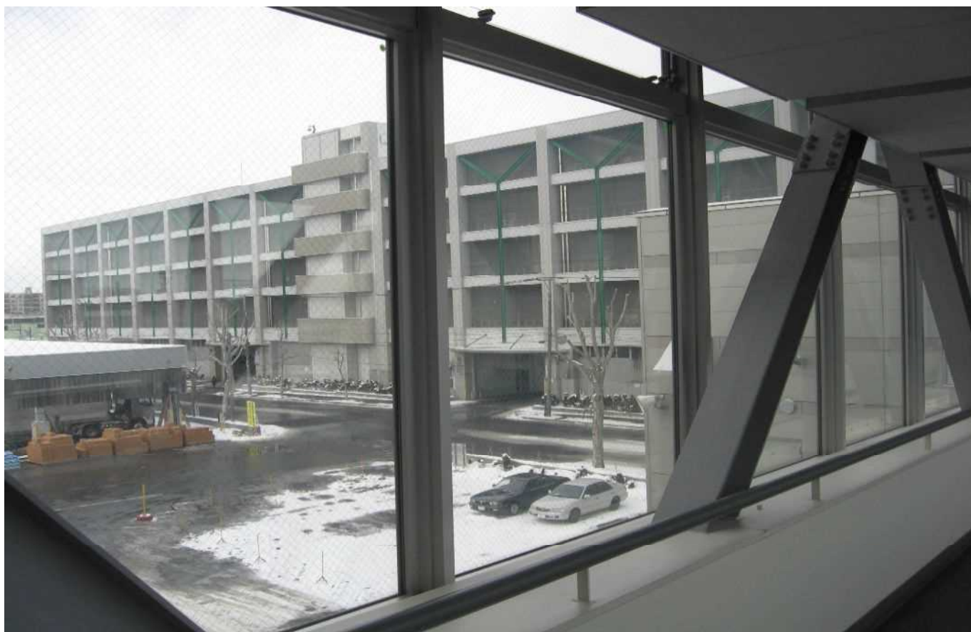
渡り廊下窓ガラス（内側）
