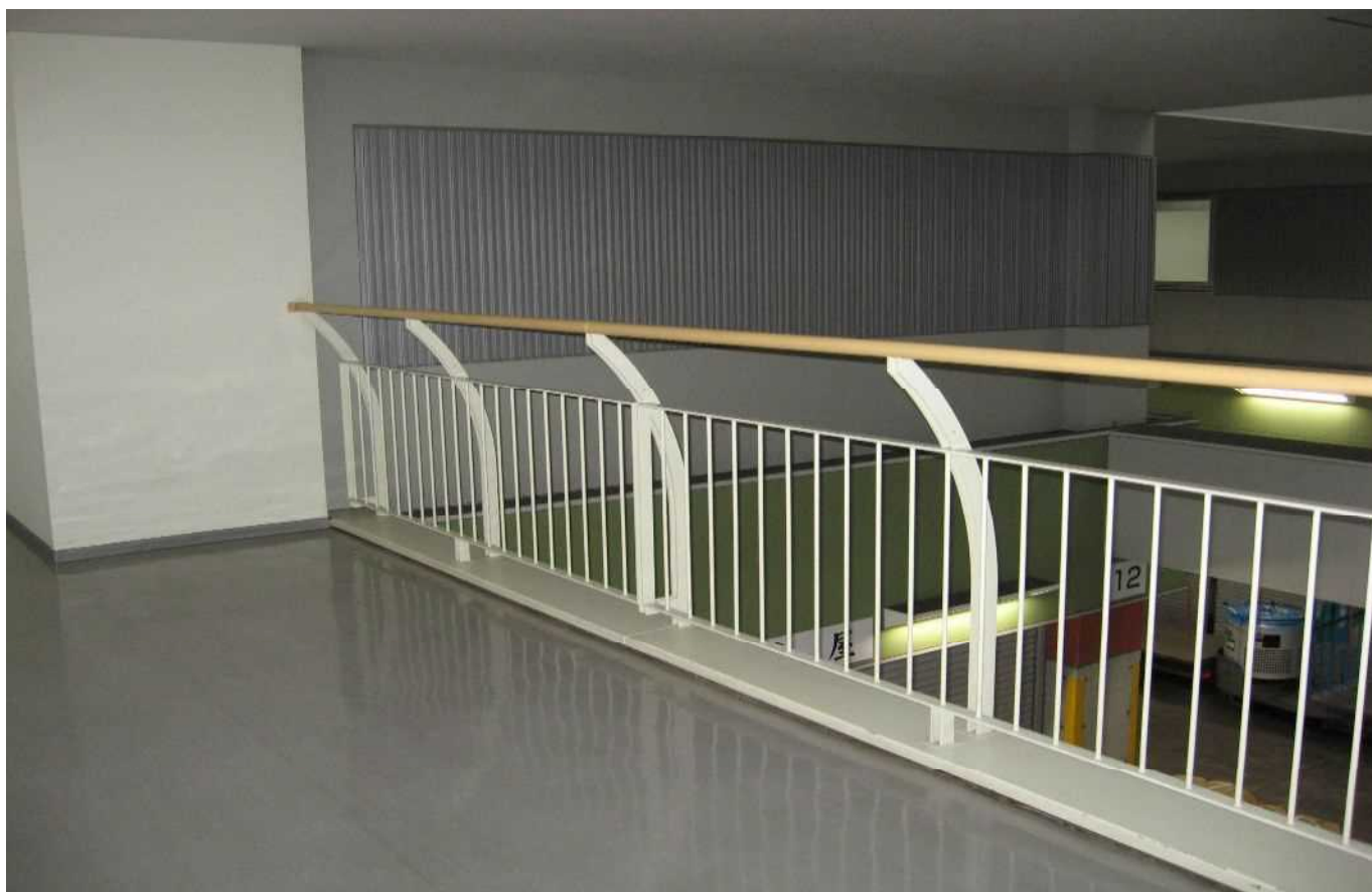
青果棟 2階仲卸事務所通路側手すり
