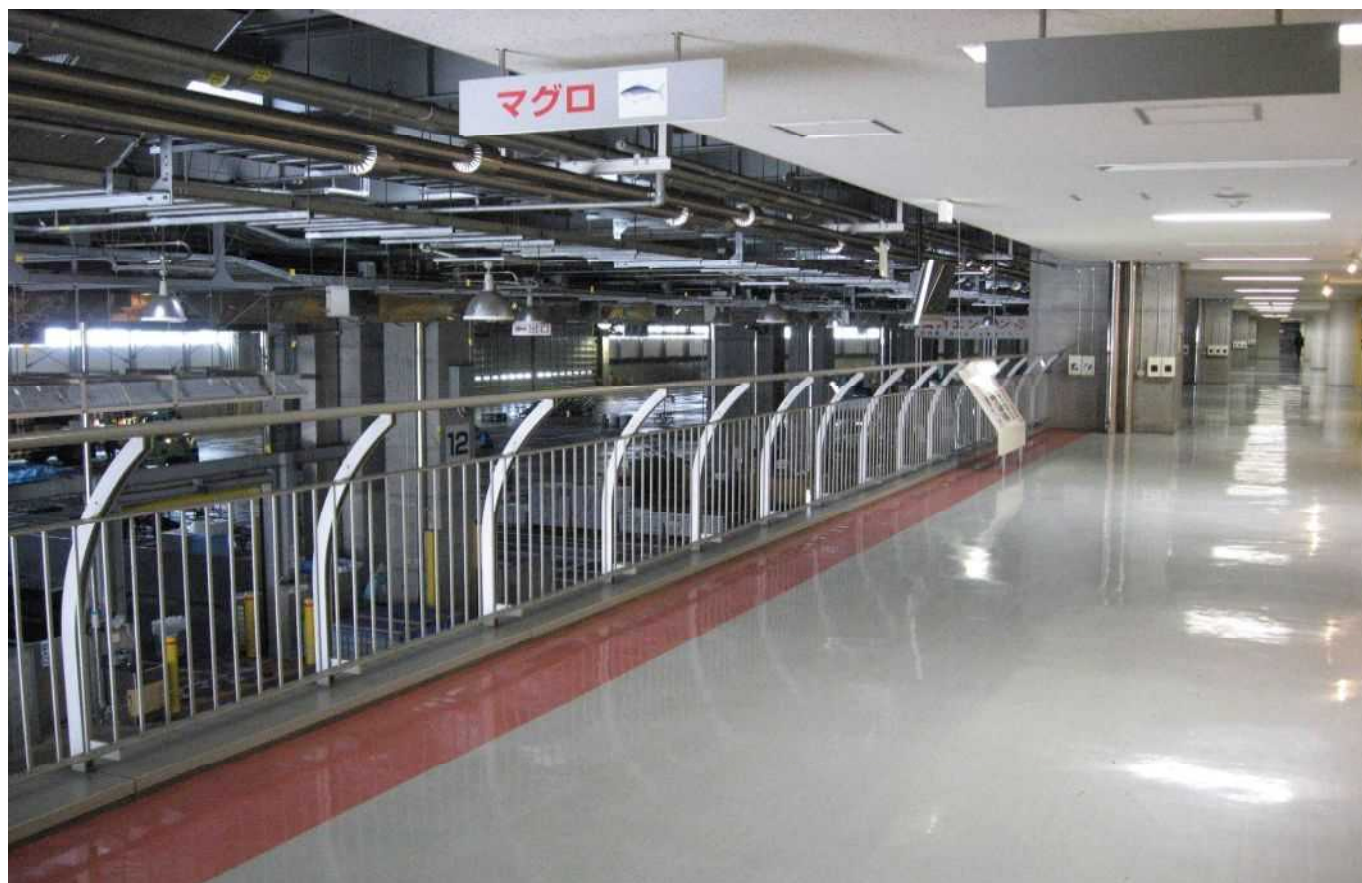
水産棟 2階見学者通路手すり
