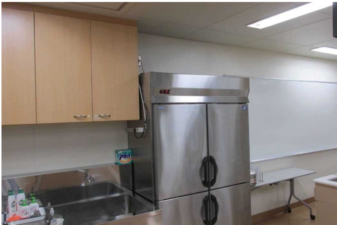
調理実習室内冷蔵庫の上部
