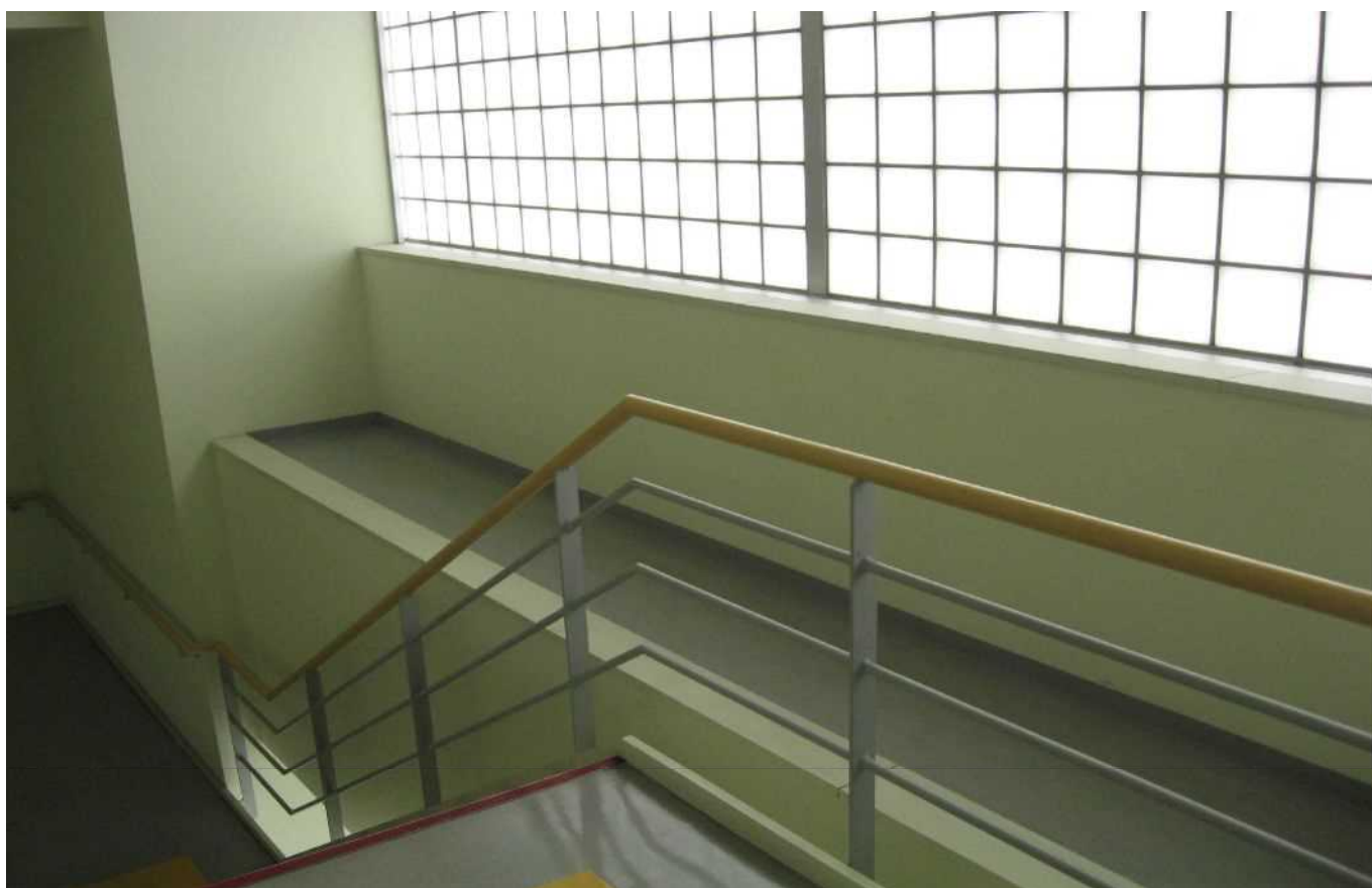
青果棟階段室内壁及び窓台（窓ガラス除く）
