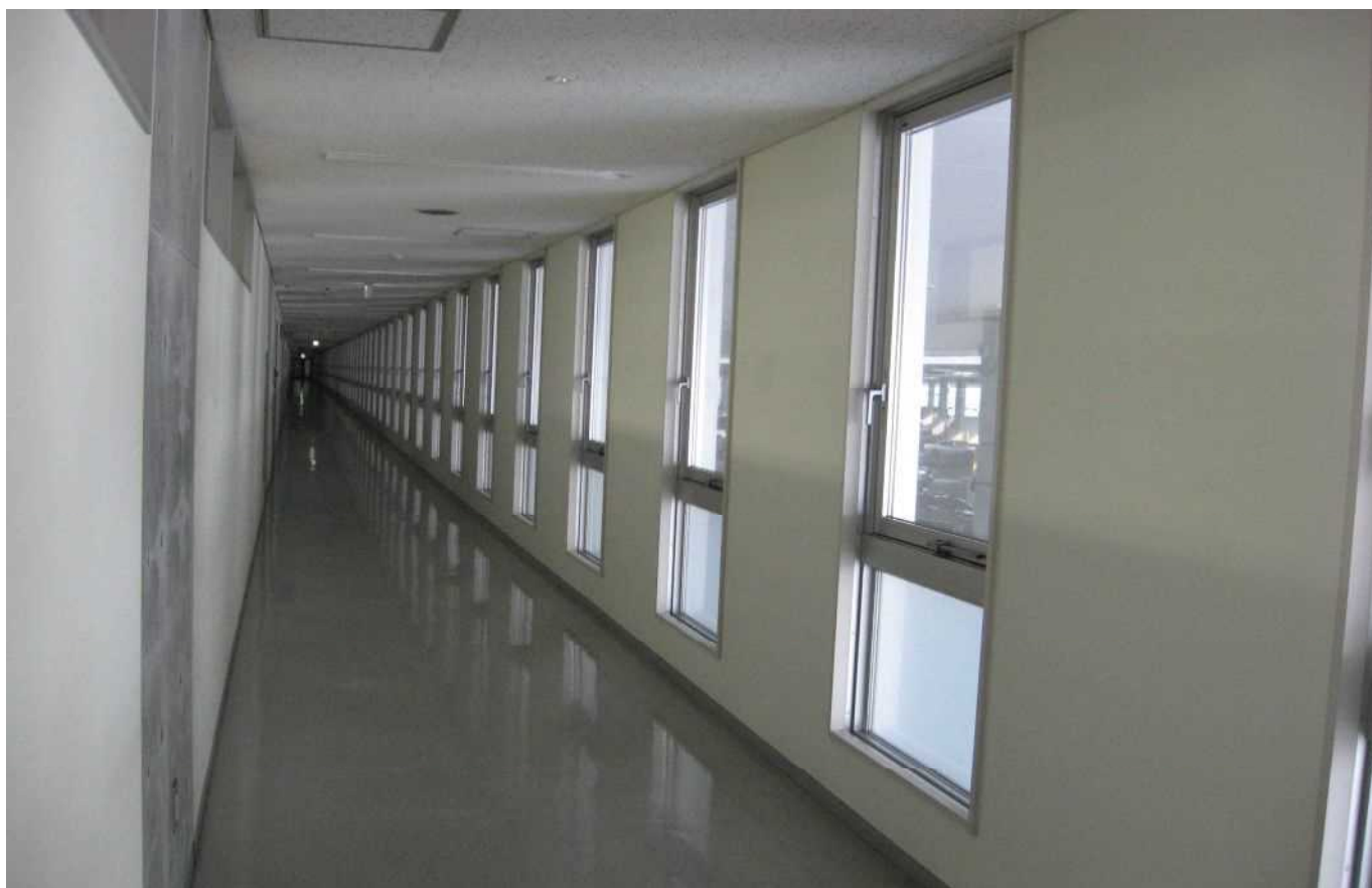
青果棟 2階 仲卸事務所側通路ガラス (9 9組) ※ 上下で1組
