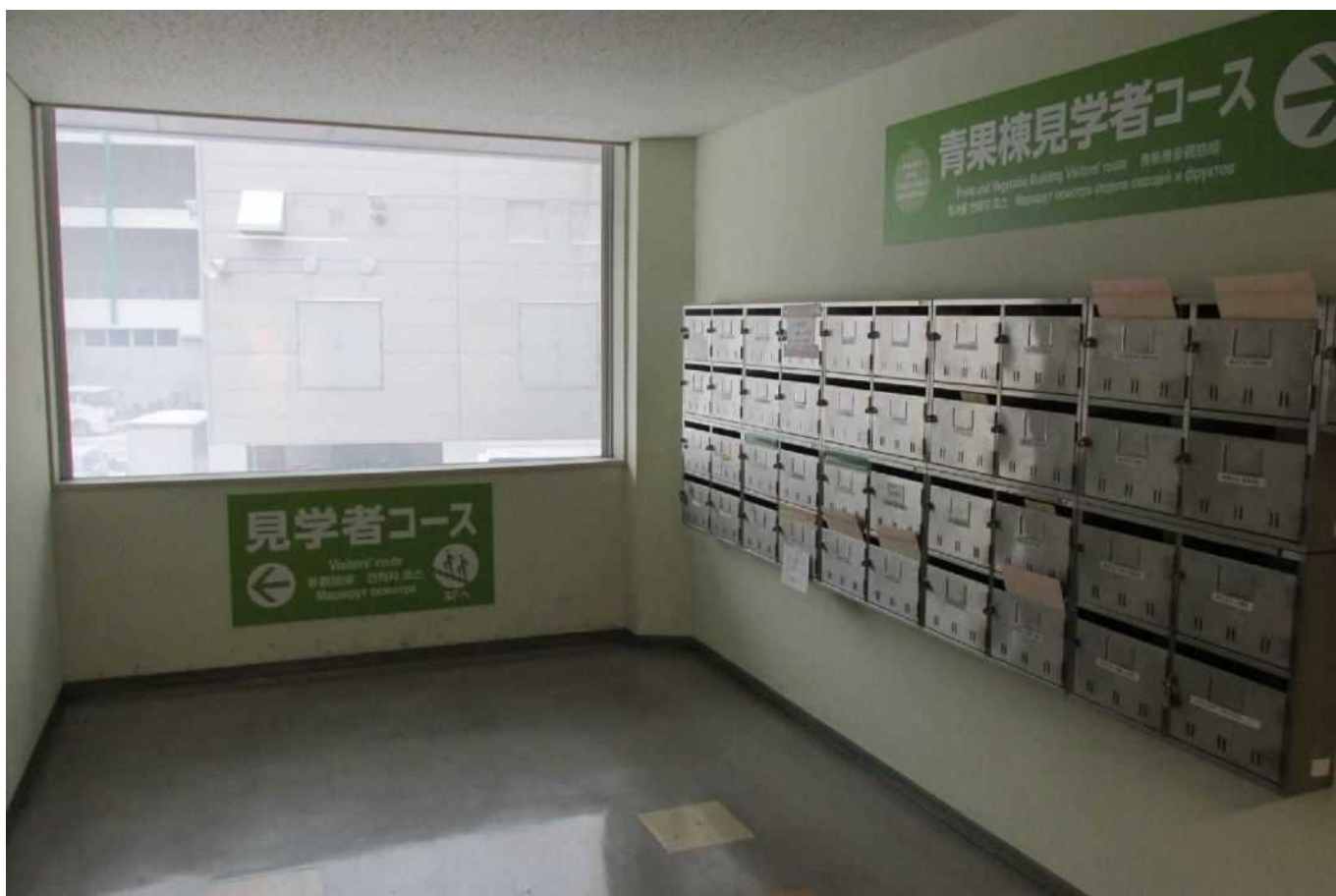
青果棟北側エレベーターホール窓ガラス及び窓台
