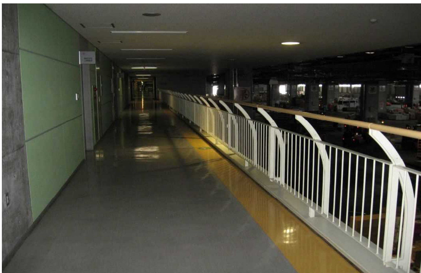
青果棟 2階見学者通路手すり及び壁
