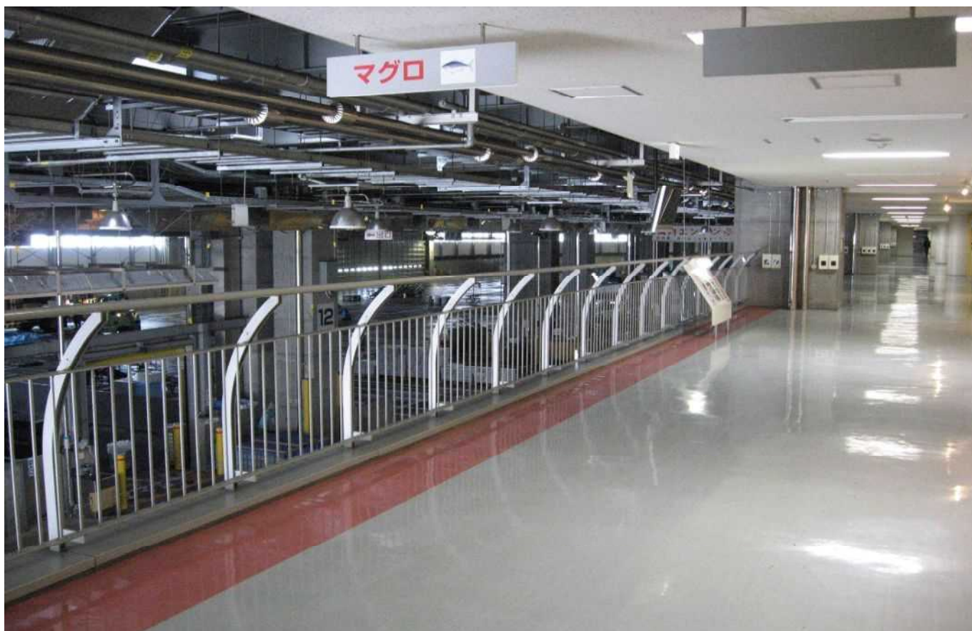
水産棟 2階見学者通路手すり
