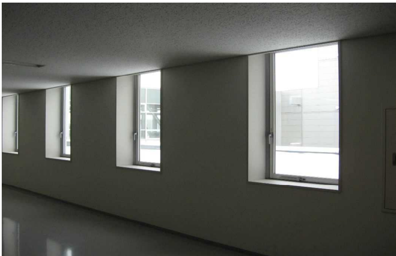
青果棟 3階 渡り廊下側通路窓ガラス (1 3枚)
