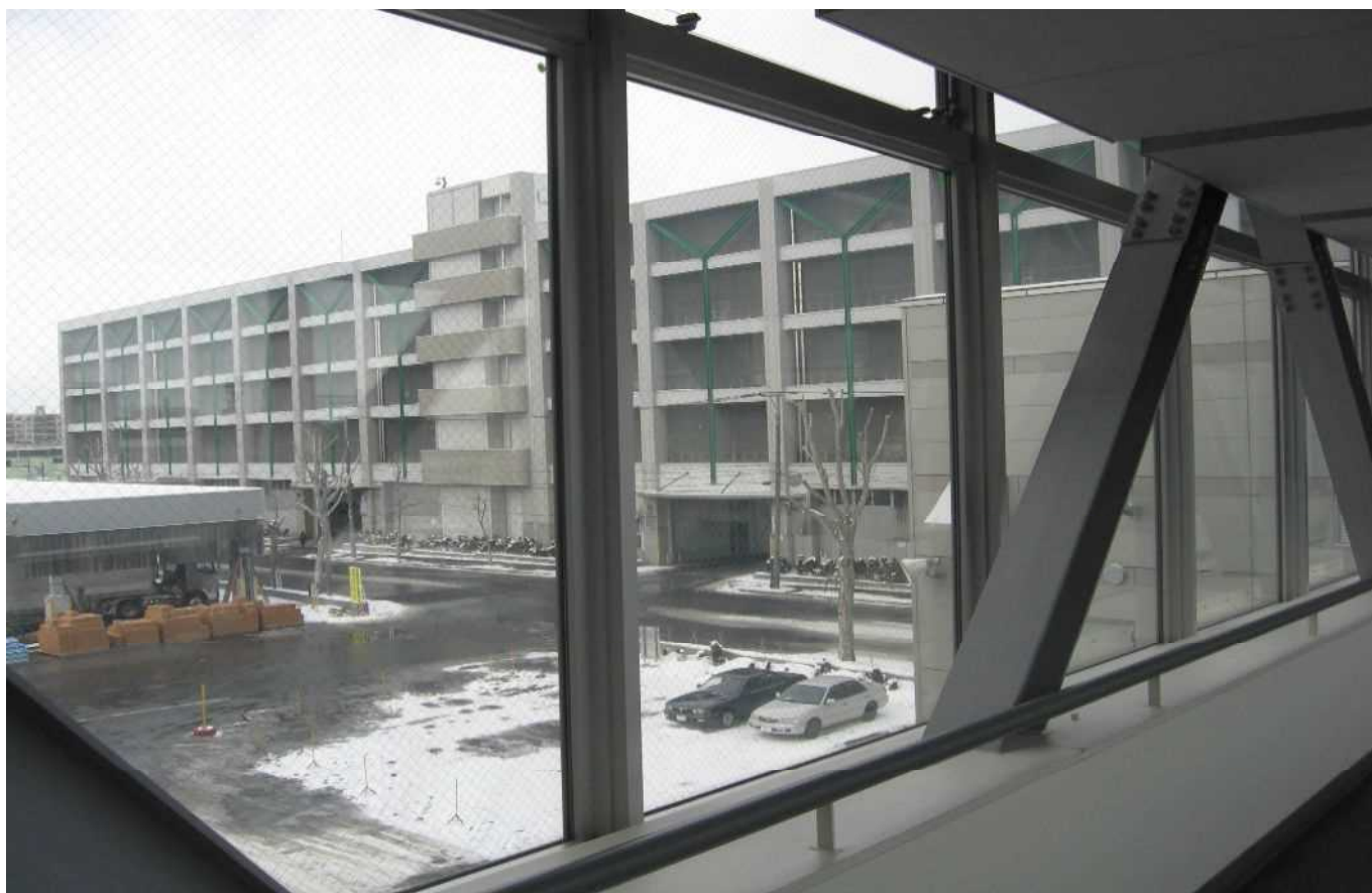
渡り廊下窓ガラス（内側）
